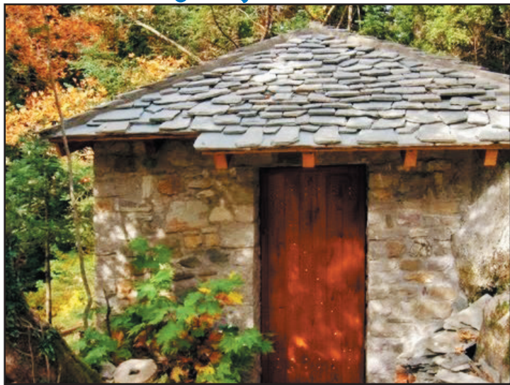
Ο νερόμυλος στην σημερινή του κατάσταση ανακαινισμένος και σε λειτουργία.
