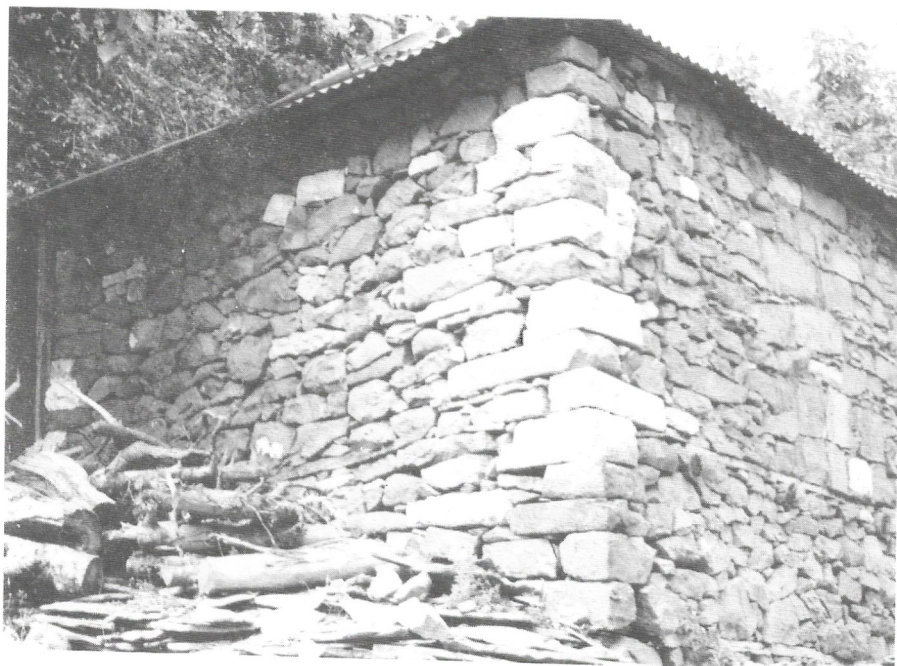
Λιθοδομή με διάφορα είδη πέτρας.
