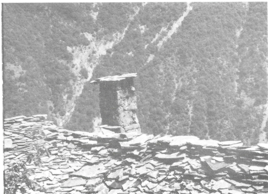
Εξωτερικό τζακιού και στέγη καλυμμένη με πλάκες.
