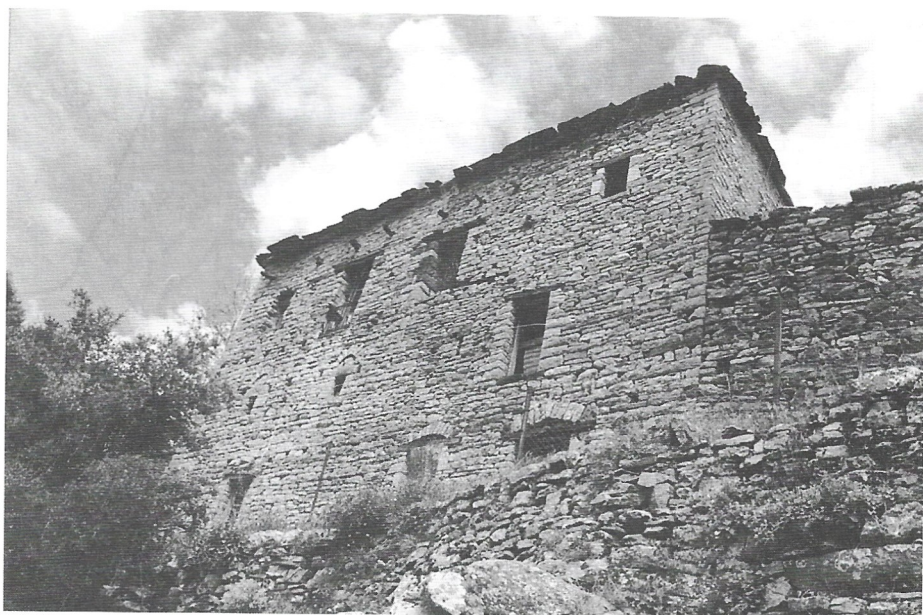
5. Νότια όψη της Σχολής Σχολής Γραμμάτων ως υφίσταται σήμερα.
