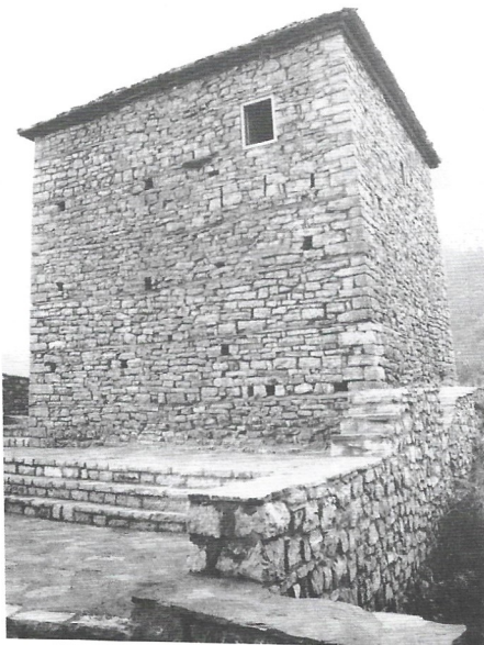
14. Η Ανατολική όψη του Ανατολικού Πύργου διάτρητη από πολεμίστρες. Διακρίνονται τα ξύλινα διαζώματα στους τοίχους.
