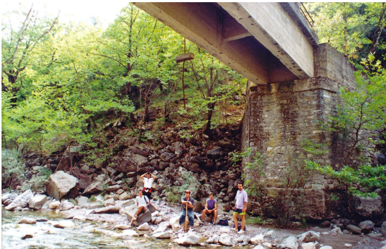
Κάτω από τη γέφυρα της Κοντίβας, 1998. Έγινε περίπου στα 1962 με τη μεταφορά των υλικών (σίδερα - τσιμέντο) με μουλάρια μέσα από τη διαδρομή του Κρικελλοπόταμου. Δυστυχώς, λόγω έλλειψης τεχνικών μέσων η θεμελίωση δεν άντεξε στις χειμωνιάτικες κατεβασιές του ποταμού και η γέφυρα κατέρρευσε το 2015. Φωτογραφία: Ζαχ. Ζηνέλης
