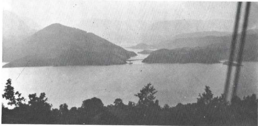
Πώς φαίνεται από τη δεξιά όχθη της Λίμνης η νέα γέφυρα Τατάρνας. (Φωτογρ. Ζημέρη).
