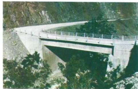
Τεχνικό έργο στο δρόμο Καρπενήσιου-'Αργινίου.
